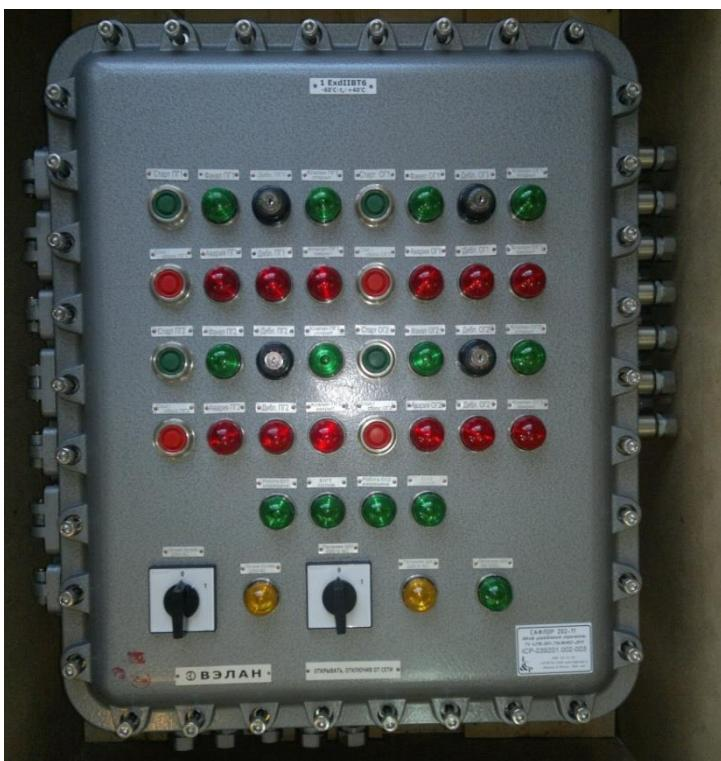
Системы САФЛОР обеспечивают безопасность технологического процесса и, по своему назначению и исполнению, относятся к средствам противоаварийной защиты, применяемым на опасных производственных объектах.
