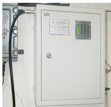
Пример размещения Шкафа КШ в здании ГРС
