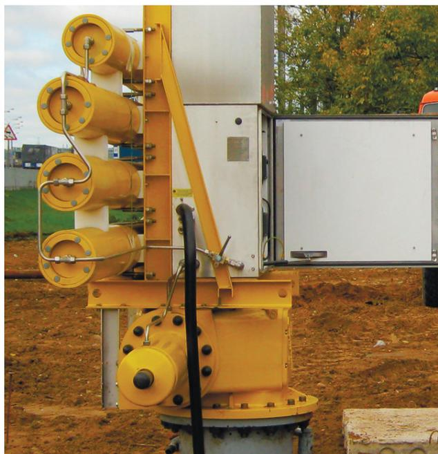
Принцип работы электрогидравлического привода основан на накоплении энергии рабочей среды в пневмогидроаккумуляторе при помощи насоса с электродвигателем, что позволяет в случае отключения электропитания произвести аварийную перестановку шарового крана.
