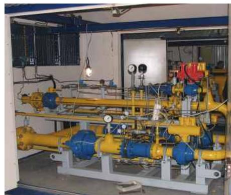
АГРС «ВОЛГА» изготавливаются производительностью от 2 до 250 тыс.  $\text{нм}^3/\text{ч}$  с максимальной степенью заводской готовности и оснащаются всеми необходимыми системами жизнеобеспечения. Оборудование АГРС устойчиво к сейсмическому воздействию интенсивностью до 9 баллов по шкале MSK-64.
