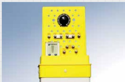
Контроллер МКИ, установленный в КИП
