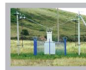
установки электрохимической защиты газопроводов (СКЗ)
