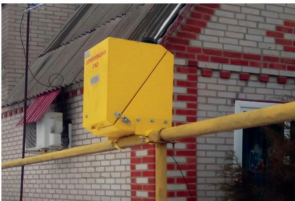
Автономная система АКТЕЛ-2-ДИ на участке газопровода.
