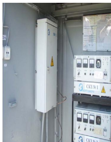
Блок-бокс УКЗ имеет два изолированных отсека. В первом отсеке расположен трансформатор подстанции 10/0,23 кВ; во втором – СКЗ (преобразователи напряжения для катодной защиты)
