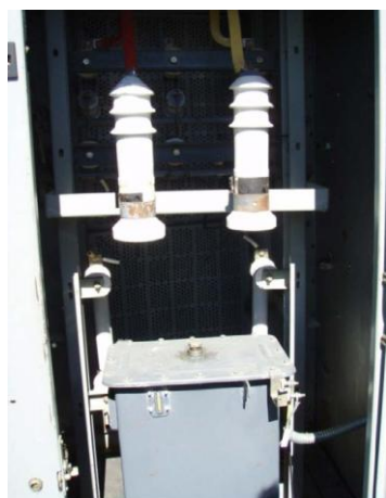
Блок-бокс УКЗ имеет два изолированных отсека. В первом отсеке расположен трансформатор подстанции 10/0,23 кВ; во втором – СКЗ (преобразователи напряжения для катодной защиты)
