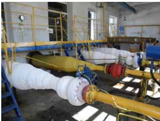
Объект до замены оборудования
