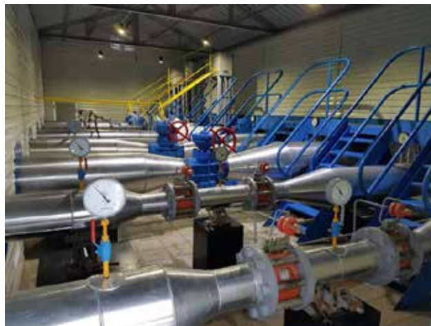
Объект до замены оборудования
