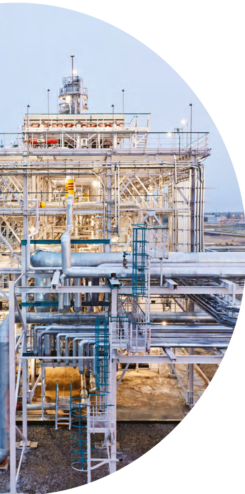
ПАО Сибурхолдинг (СибурТюменьГаз. Вынгапуровский ГПЗ)
