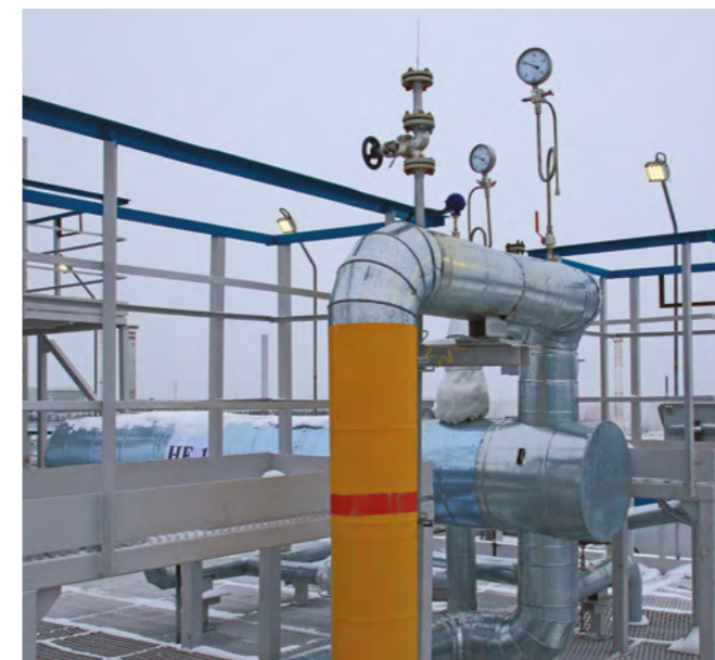
ПАО Сибурхолдинг (Южно-Балыкский ГПЗ)
