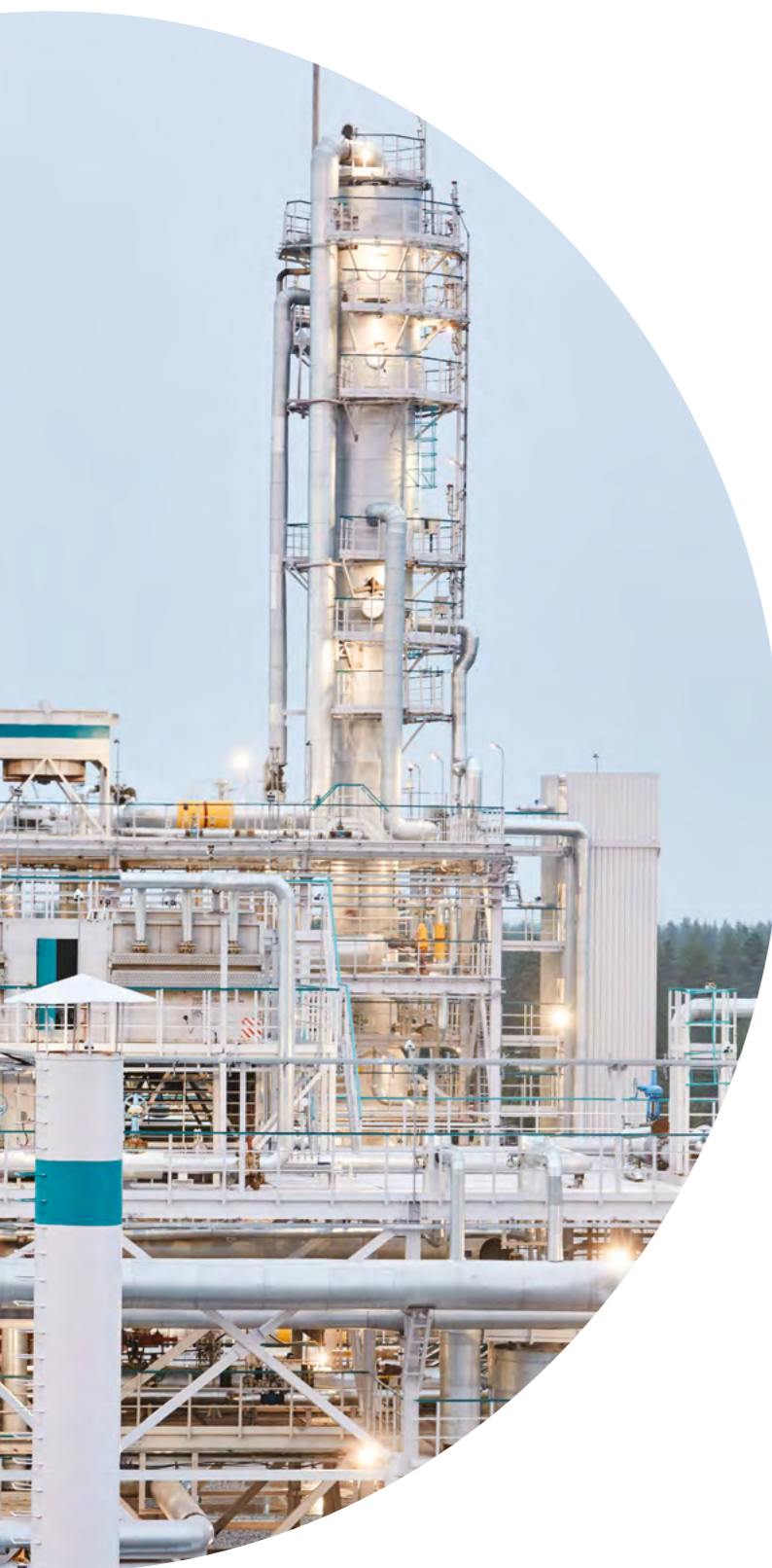
ПАО Сибурхолдинг (СибурТюменьГаз. Вынгапуровский ГПЗ)
