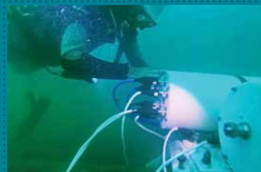
Пуско-наладочные работы на газопроводе «Джубга-Лазаревское-Сочи»
