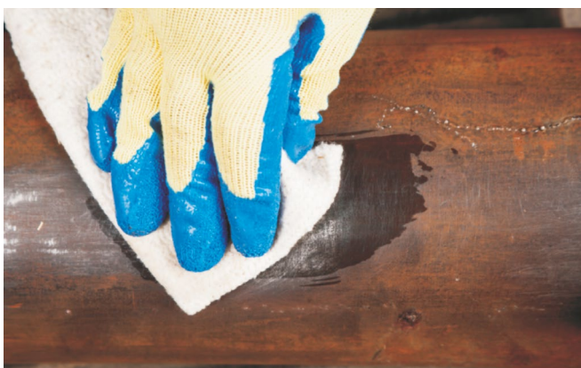
Обезжиривание поверхности трубы
