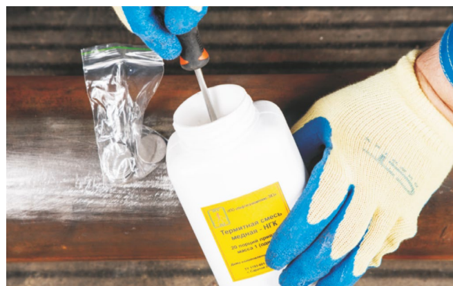
Перемешивание термитной смеси
