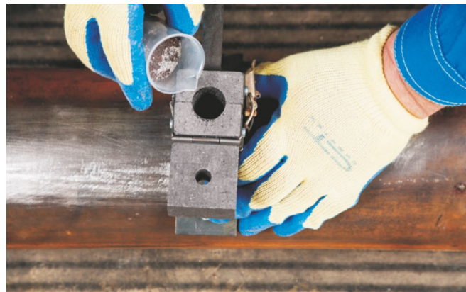
Засыпка порции термитной смеси в многоразовую тигель-форму
