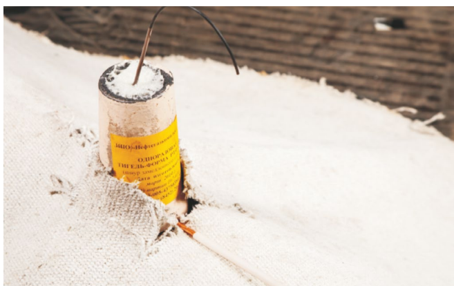
Установка одноразовой тигель-формы
