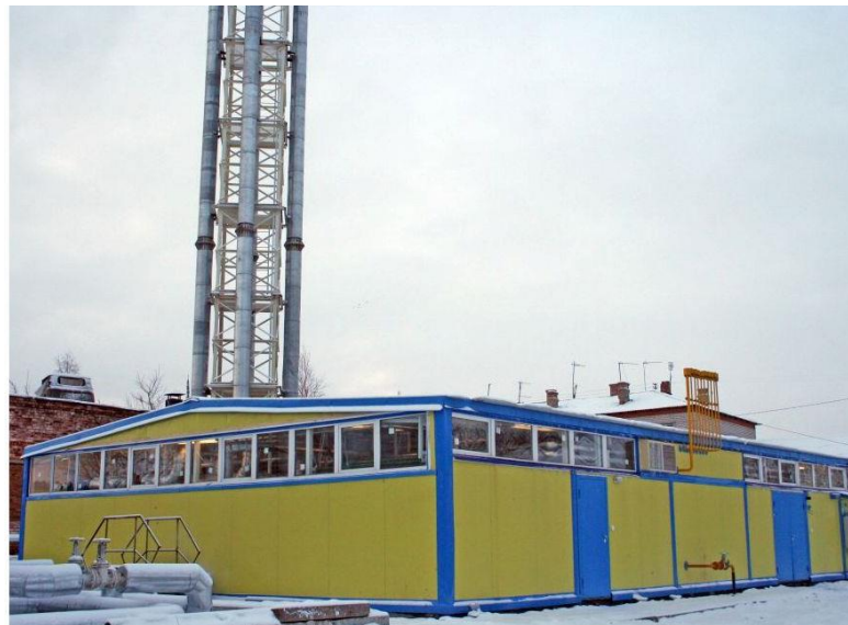
Блочно-модульная котельная, г.Арамилы, мощность 6 МВт.
