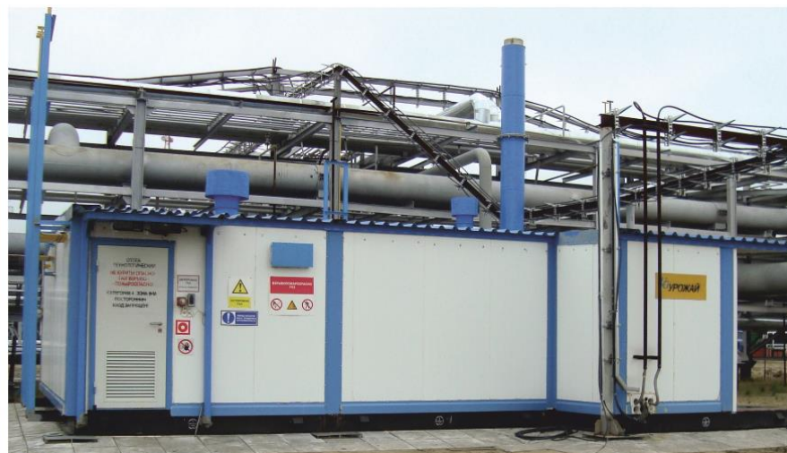
УПТПГ для Самбурского месторождения Производительность 10 000 \text{nm}^3/\text{час}
