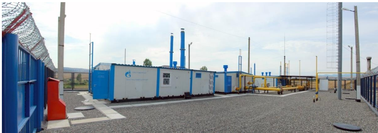
АГРС «Урожай 30», производительностью 30 000 \text{нм}^3/\text{час}
