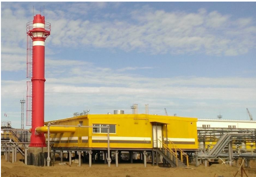
Блочно-модульная котельная, Северо-Ванкорское месторождение, мощность 6 МВт.
