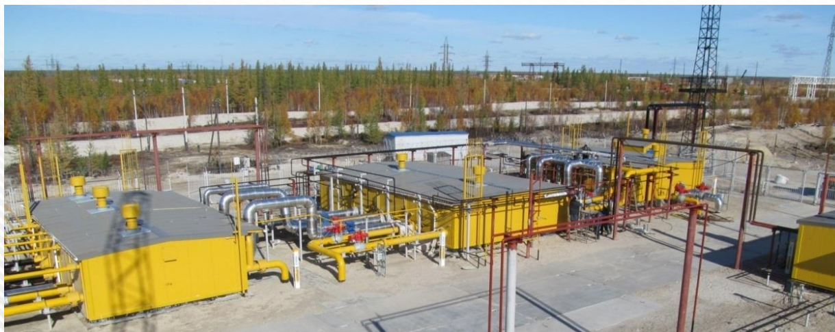
АГРС «Урожай-144», производительностью 144 \text{нм}^3/\text{час}
