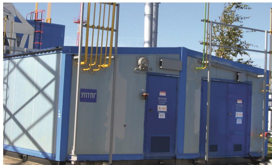
УПТПГ «Байдарацкая» Производительность 45 000 \text{м}^3/\text{час}
