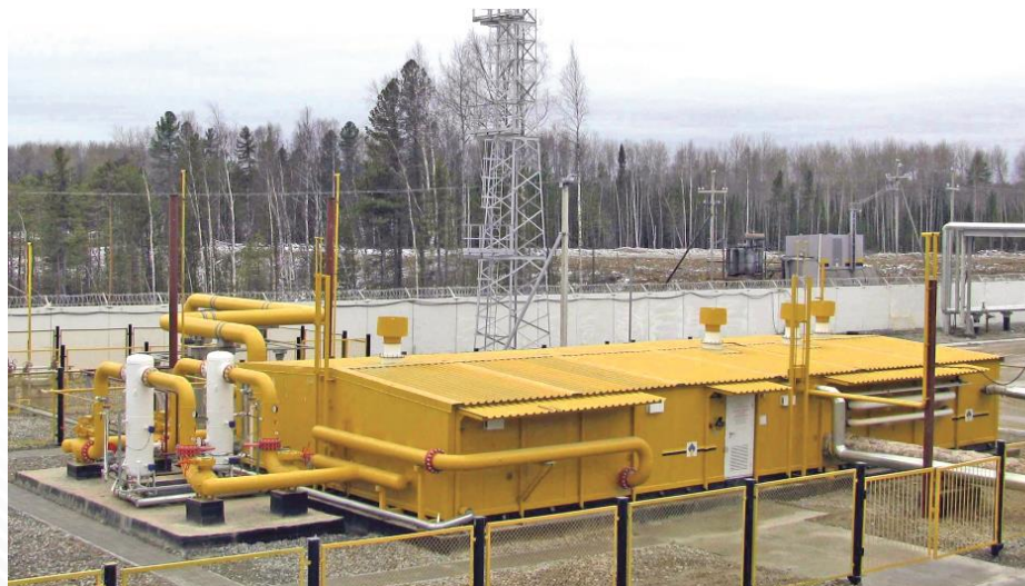
УПТПГ «Приобская» Производительность 110 000 \text{м}^3/\text{час}
