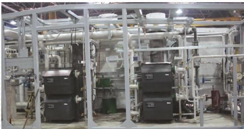
Сбор блочно-модульной котельной.
