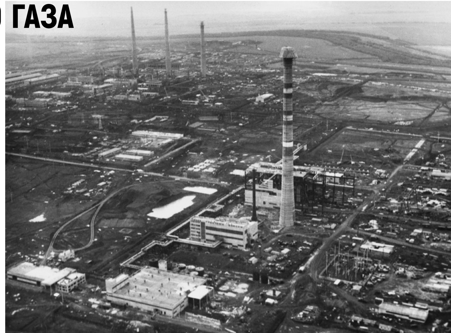
Панорама строительной площадки ГПЗ, 1976
